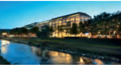
Das viel beachtete Tamedia-Projekt in Zürich zeigt, wo Holz beim Bau heute seinen Platz finden kann.
