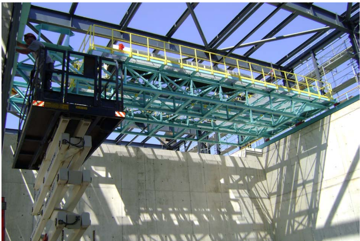
Holzchnitzel - Verteileranlage in der Holzlogistikhalle des HHKW Aubrugg AG
