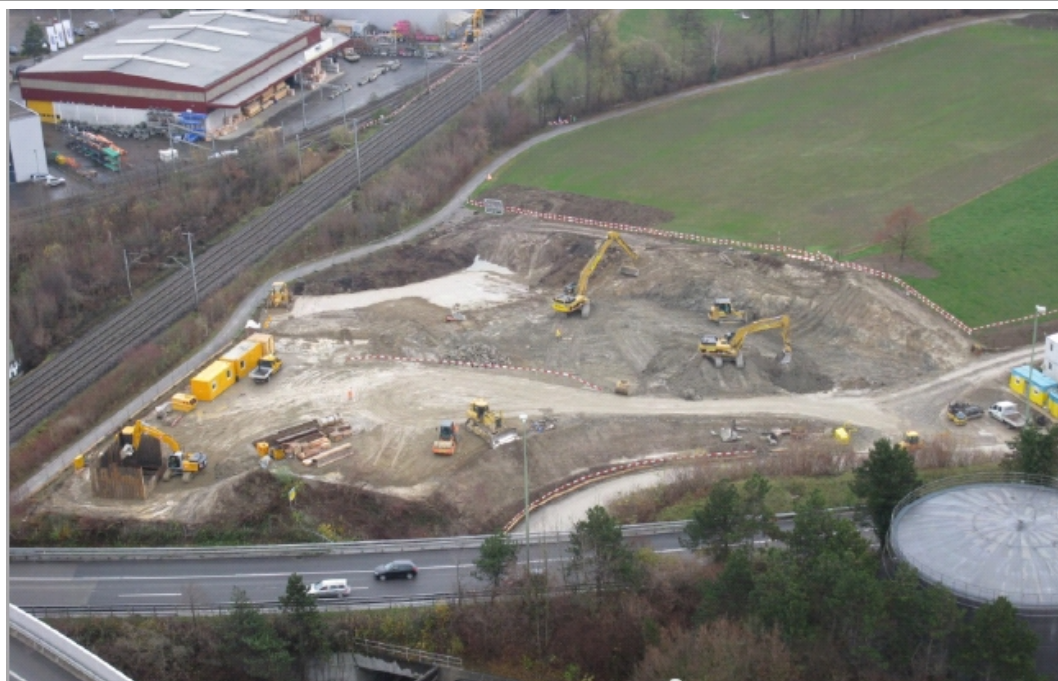
Baustelle „Holzlogistik“ HHKW Aubrugg AG.
